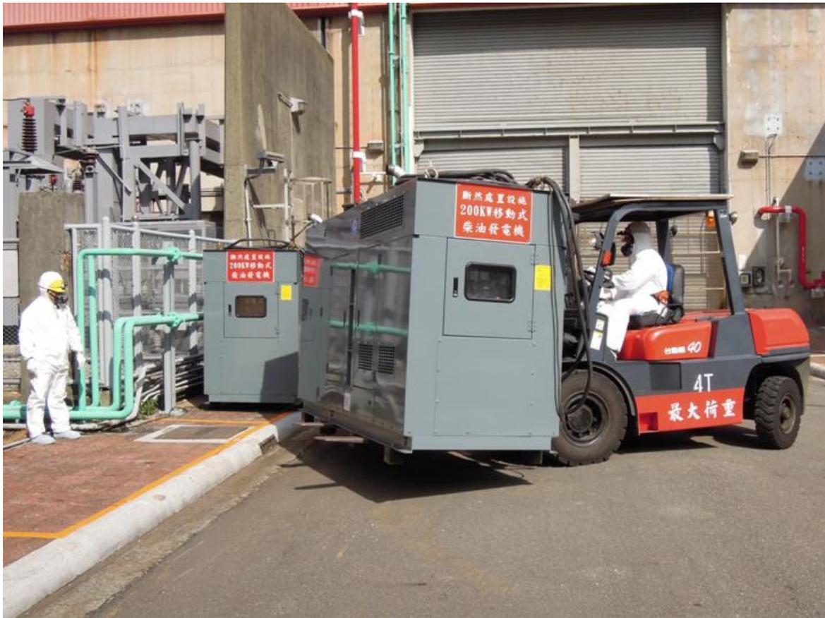
斷然處置第一階段列置—拉設移動式柴油發電機供電電纜至 1B3/1B4 480V 負載中心
