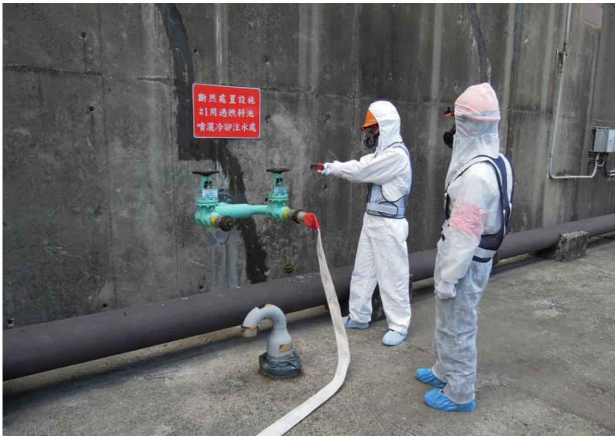
斷然處置第一階段列置—將水帶接到#1 號機用過燃料池噴灑冷卻注水處
