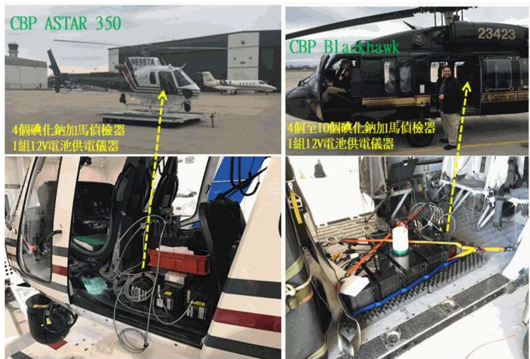
圖 5 RAP5 採用航空器上之 AMS 儀器安裝實況
