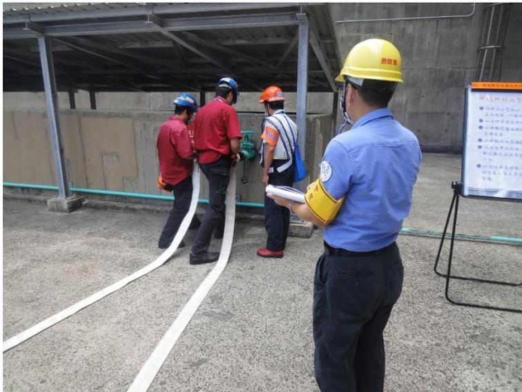
圖 4-4 核能二廠冷凝水儲存槽補水至反應爐列置
