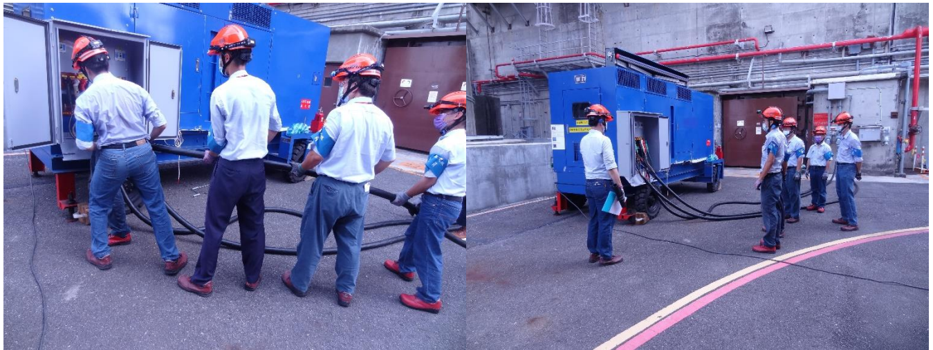
圖 5 9 月 6 日 480V 移動式柴油發電機供電演練
