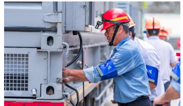
圖 25 電源車(4.16kV)引接演練
