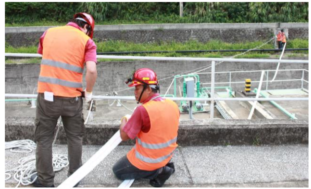
圖 23 生水池水源引接至移動式設備演練
