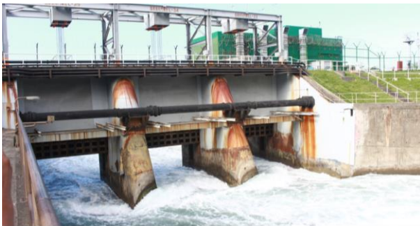
圖 24 海嘯閘門啟閉演練
