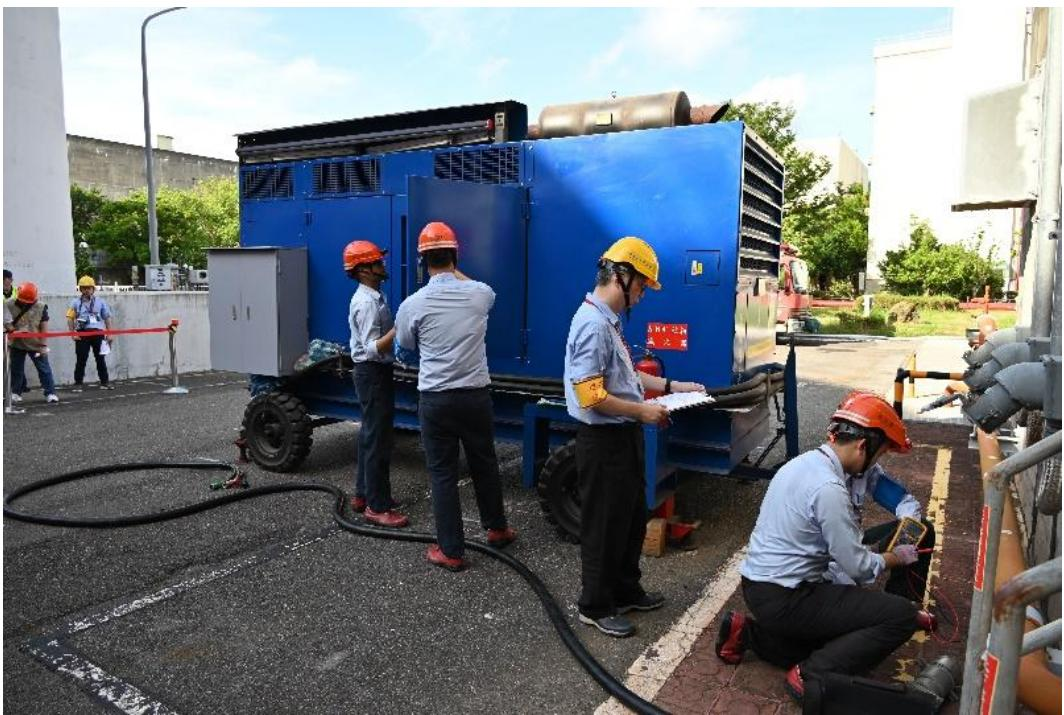
圖 4-5 備用電源 480V 電源車列置與引接演練
