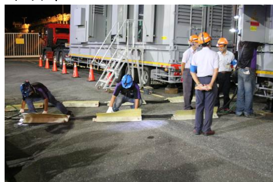
4.16KV 電源車引接演練
