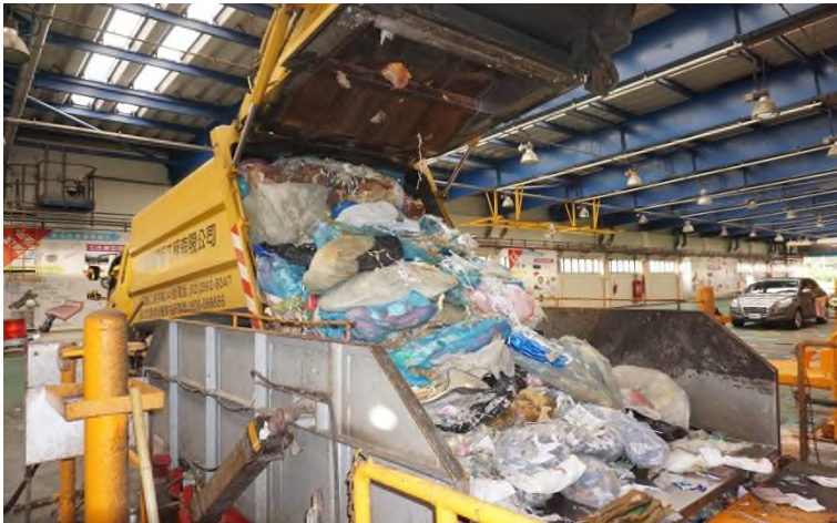
將垃圾車駛入廠區內倒出垃圾
