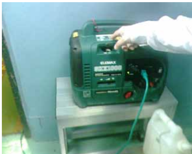
移動式汽油發電機臨時電源將 120VAC 轉換成直流電源後供應至 SRV 與 RCIC 控制電源
