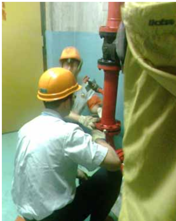
消防水系統至 RHR-B 迴路盲板拆裝演練
