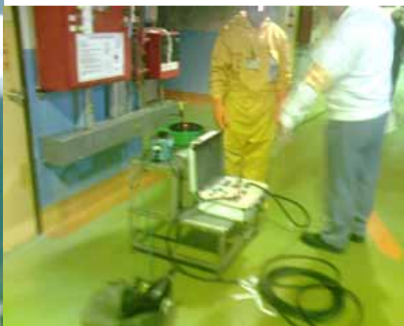
移動式汽油發電機臨時電源將 120VAC 轉換成直流電源後供應至 SRV 與 RCIC 控制電源
