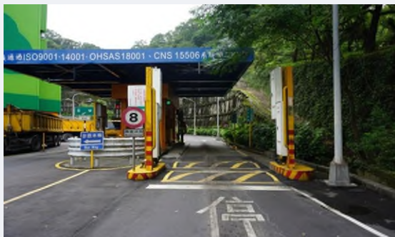
垃圾焚化廠之門框式輻射偵檢器
