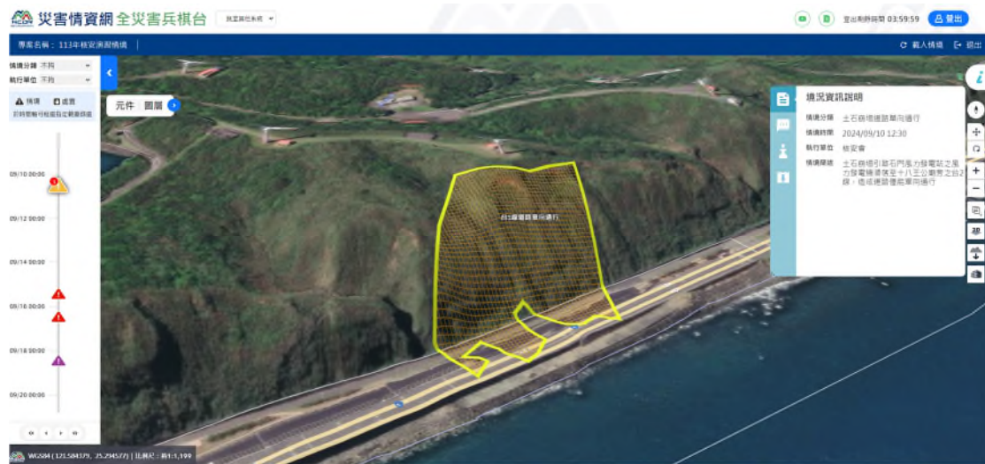
圖 45 土石崩塌造成道路阻斷
