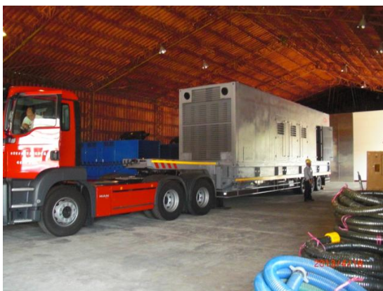
4.16kV 電源車拖曳作業
