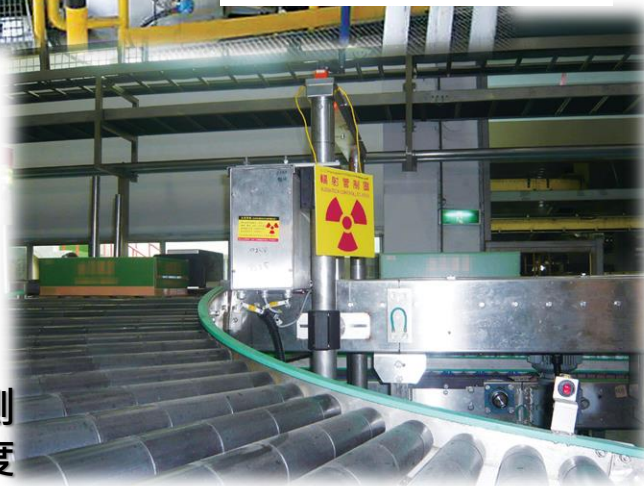
化工廠利用 輻射確認管槽液位
