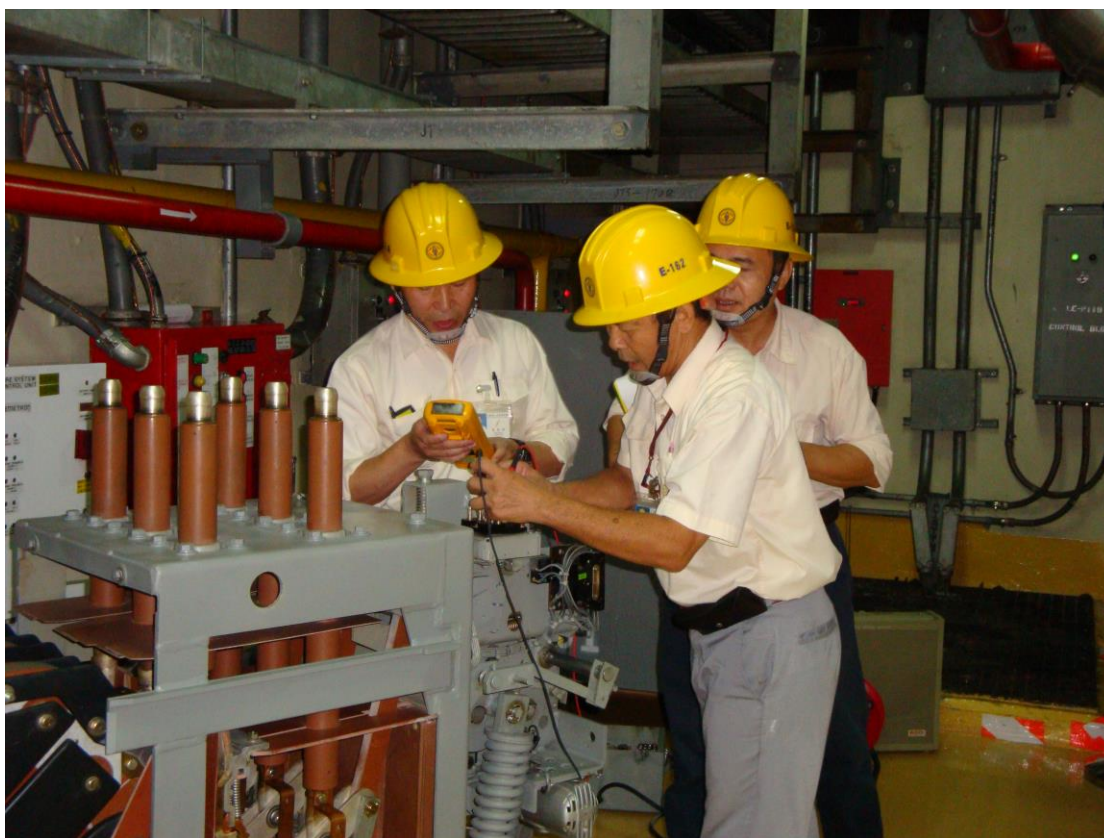
緊急再入搶修作業
