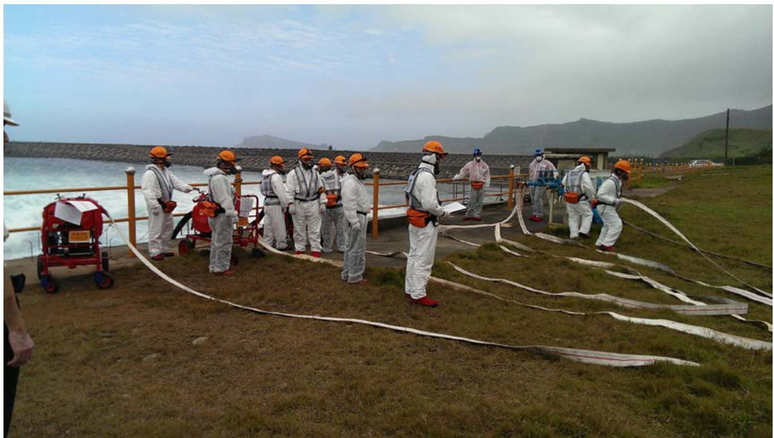
出水口抽取海水灌至核能二廠排洪渠道
