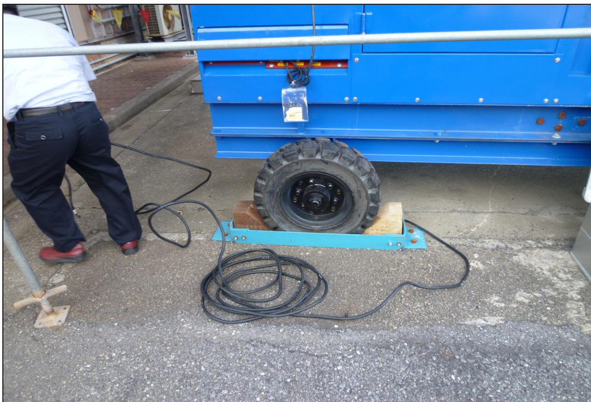
斷然處置第一階段列置-拉設移動式柴油發電機供電電纜至 ZY-F001
