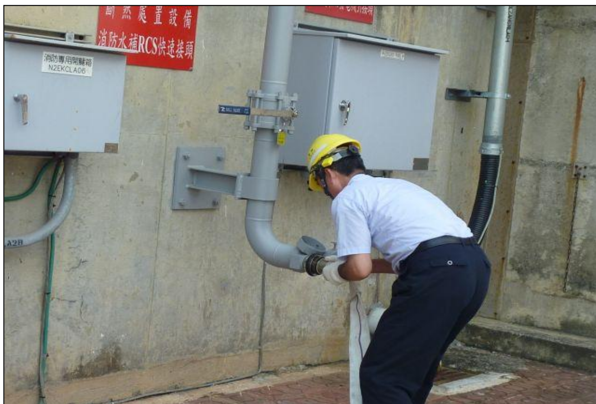
斷然處置第一階段列置-將水帶接到二號機 BL-V715 下游快速接頭
