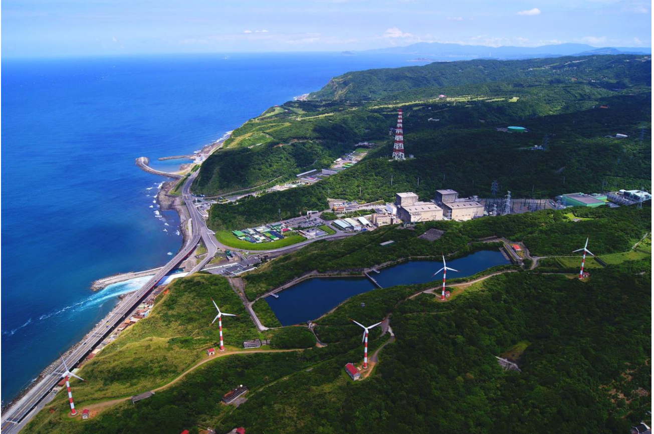
圖 1.4 核一廠廠區空照圖
