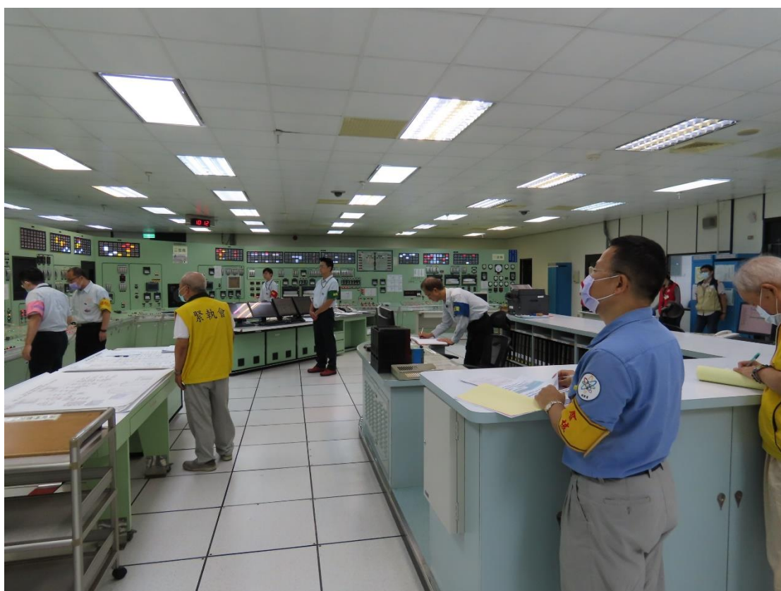
圖 2 核能二廠機組事故處理演練
