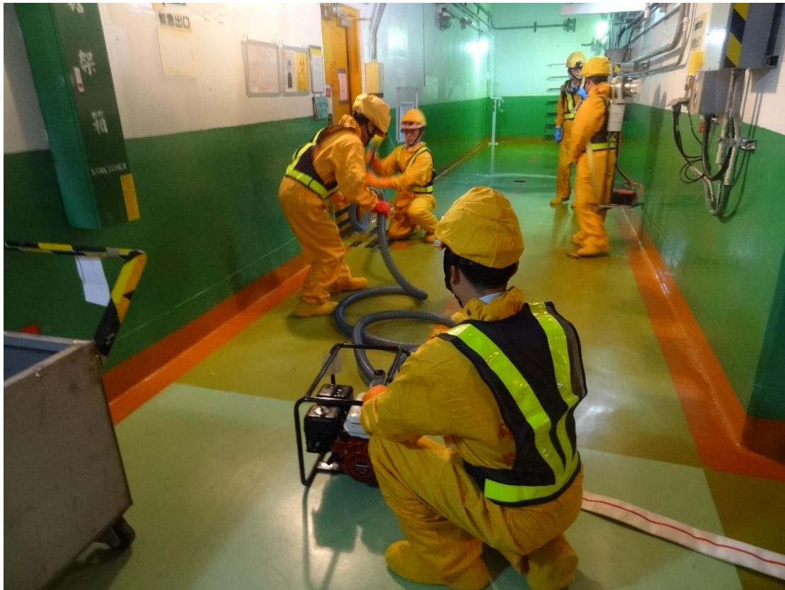
圖 4 特定重大事故策略指引(SMI)KS.2-05 一號機用過燃料廠房排水作業演練
