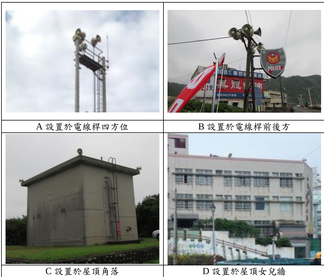
圖 3.1-1 核能電廠警報站設置說明圖
