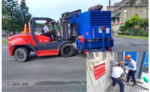
圖 14 - 核能三廠 480V 柴油發電機運送及供電演練
