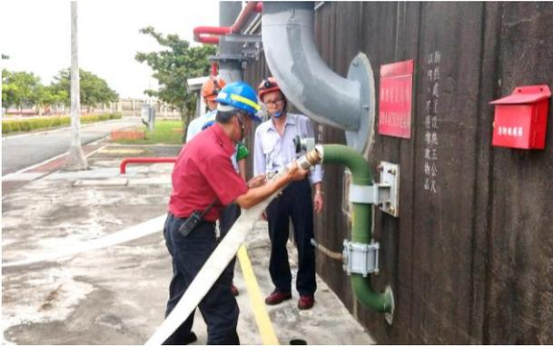
圖 15 - 核能三廠冷凝水儲存槽補水
