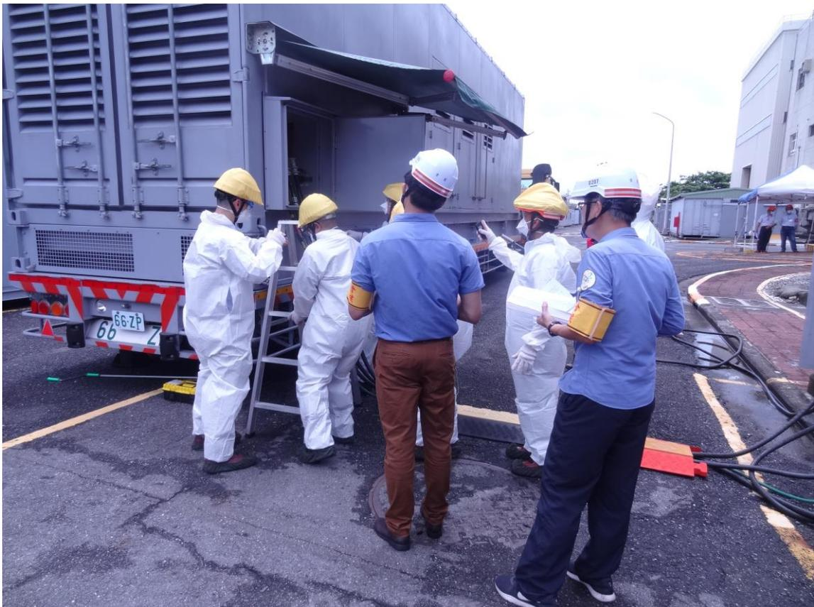
圖 4 4.16kV 電源車引接演練
