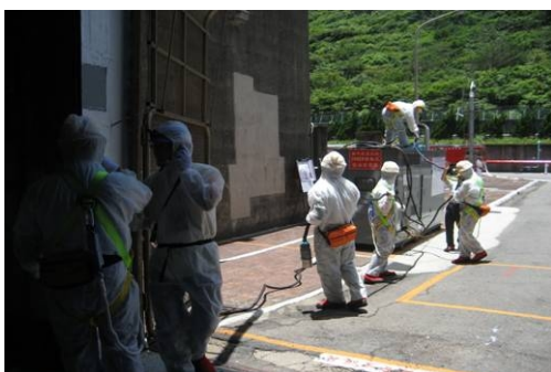
480V/200kW 移動式柴油發電機引接演練
