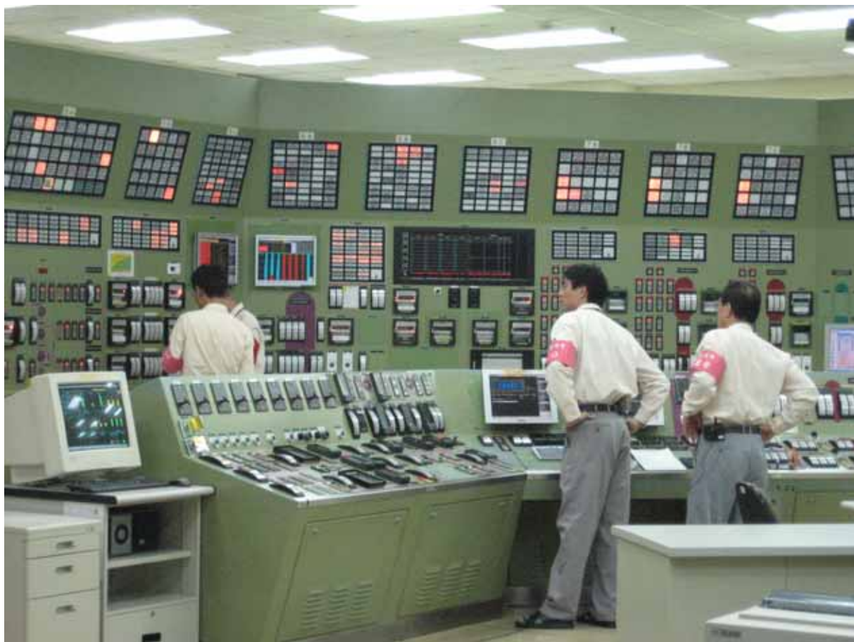
機組運轉及事故處理演練
