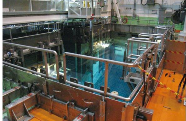
核二廠用過核子燃料啜吸檢驗作業專案檢查
