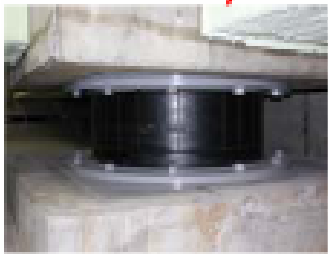
8プラグ入り種間ゴム(8台) (変形を元に戻し揺れを吸収する)
