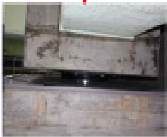
滑り支承(12台) (摩擦が少ない板上を滑る)
