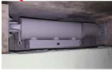
オイルダンパー(4台) (地震の揺れを吸収する)
