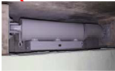
オイルダンパー(4台) (地震の揺れを吸収する)
