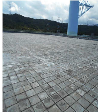
反應器廠房屋頂清洗後
