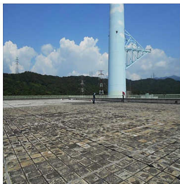
反應器廠房屋頂清洗前
