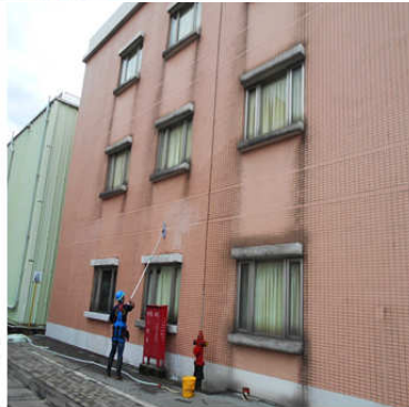
非破壞檢測大樓清洗前
