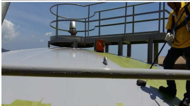
除礦水槽 上面漆
