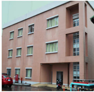
非破壞檢測大樓清洗後
