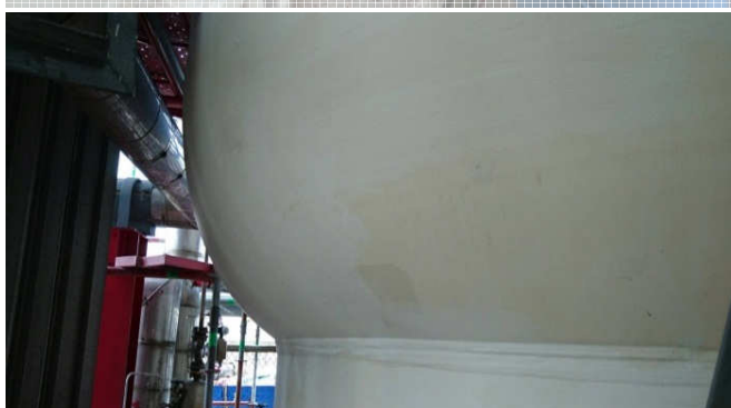
液氮槽 上面漆
