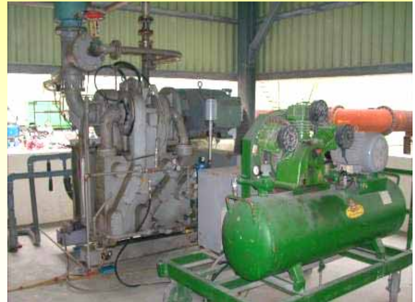
臨時空壓機 (支援正式壓縮空氣系統)
