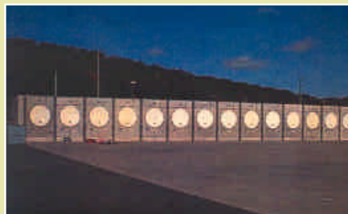
圖四十四 美國 Susquehanna 核能電廠乾式貯存圖片（水平式）
