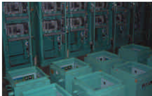
圖六十九 核能電廠強震急停裝置
