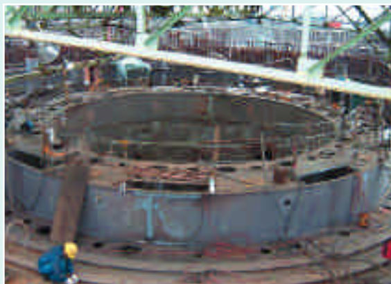
圖七十 一號機基座施工現場實景
