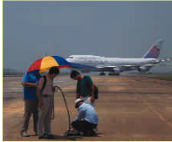
圖二十五 中正機場跑道鋪面透地雷達檢測
