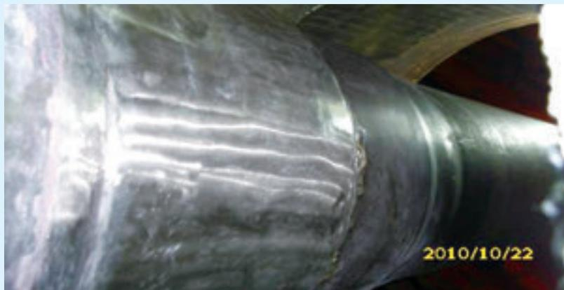
▲ 飼水管嘴覆焊層研磨完成後表面
