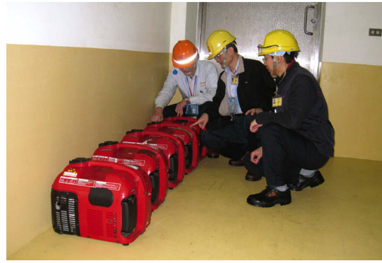
▲輻防設備用汽油發電機
