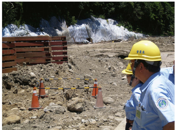
▲ 綜合計畫處同仁執行核子保防視察—檢查核能一廠乾貯設施場址
