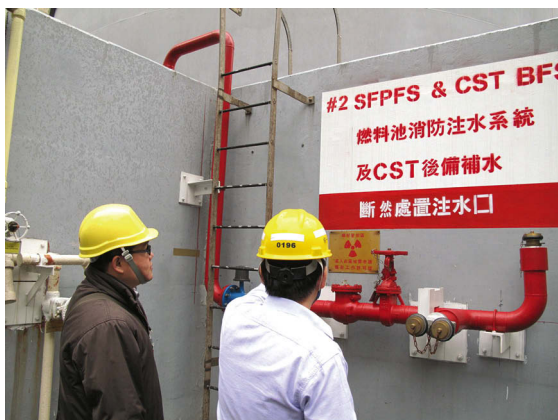
▲斷然處置設施—緊急補水至反應爐設備
