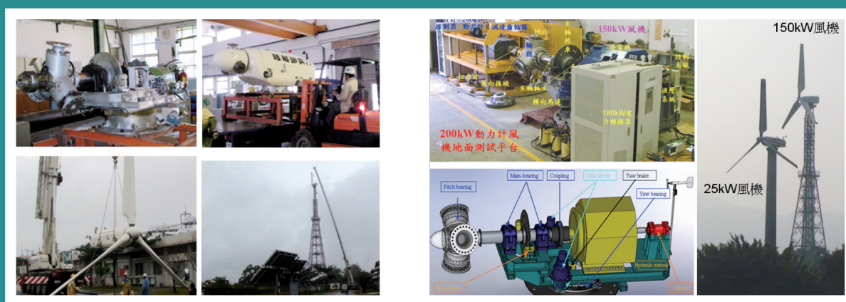
▲ 風機之組裝及吊裝
