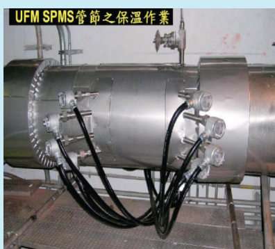
▲ 核能二廠超音波流量計系統
