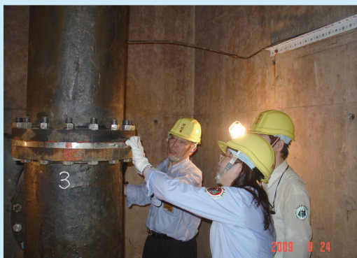
▲ 現場查證緊要海水系統管路狀況
