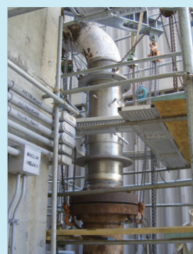
▲ 核能三廠超音波流量計系統
