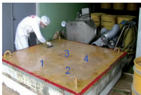
▲ 015D地下貯存庫水泥屏蔽蓋以膠體除污技術除污
