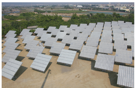
◀ MW級市電併聯型太陽光發電示範系統
