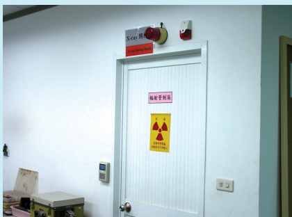
▲ 輻射源貯存場所刷卡管制系統
