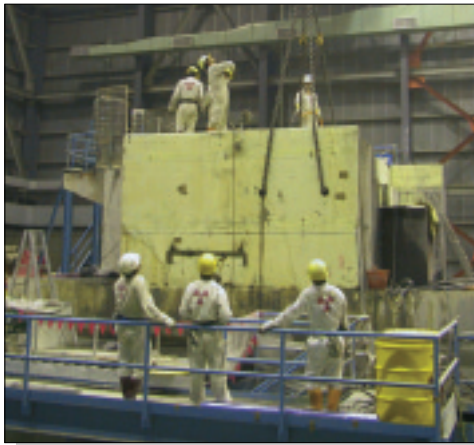
圖八十二、核研所TRR濕貯槽拆除作業
