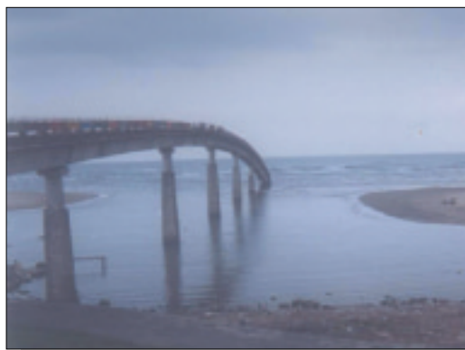
圖五、福隆沙灘受到颱風嚴重侵蝕情形
