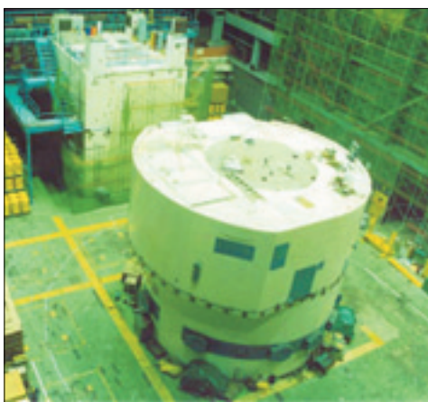
圖八十三、核研所TRR爐體移至拆裝廠房前後之情形。
