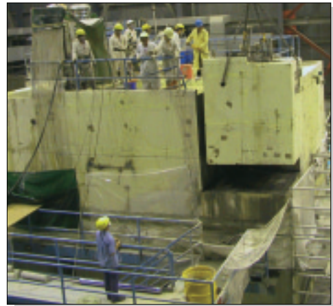
圖八十二、核研所TRR濕貯槽拆除作業
