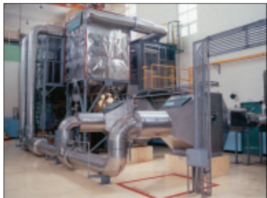
圖七十九、減容中心焚化爐廢氣處理系統
