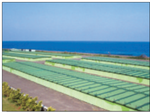
圖八十一、蘭嶼貯存場貯存溝
