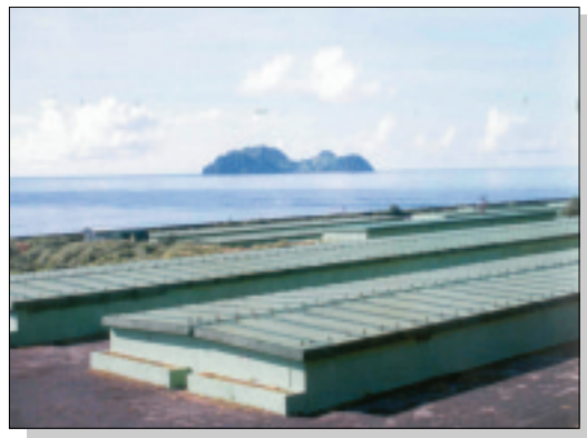
圖二十六、蘭嶼貯存場貯存溝
