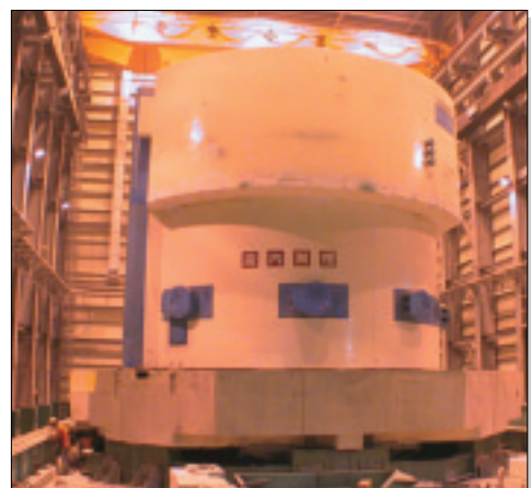
圖八十三、核研所TRR爐體移至拆裝廠房前後之情形。
