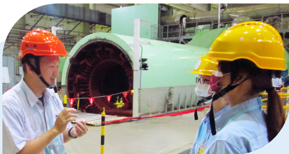
▲ 113 年 8 月 12 日執行核一廠拆除作業視察
