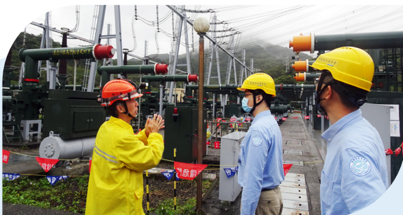
▲ 113 年 3 月 7 日執行核二廠第 1 季除役定期視察
