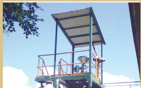
↑20公升蒸汽爆裂前處理系統
