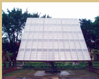
↑7.5 kW立柱式太陽光追蹤器(含承載模組)
