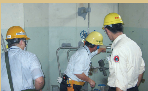
↑原能會視察員於現場陪同台電工作人員執行管路查漏
