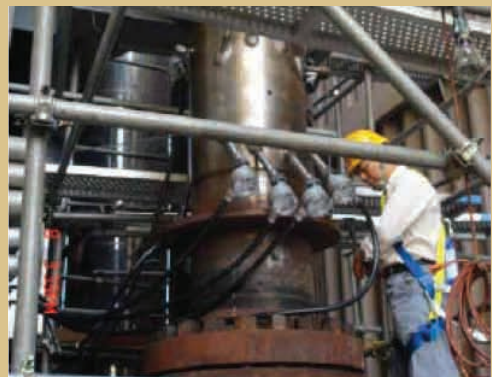
↑核能三廠超音波流量計系統現場安裝施工
