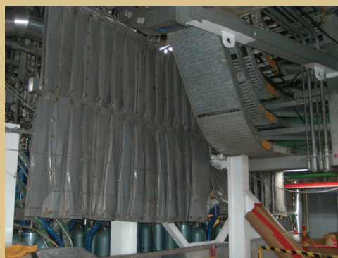
↑利用屏蔽降低工作區中輻射強度
