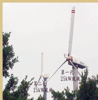
↑ 25kW新一代風機（變速永磁發電機）
