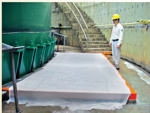
▲核能一廠緊急柴油發電機燃油槽基座結構耐震補強
