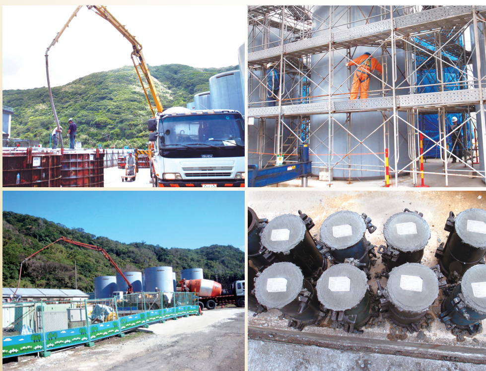
▲核一廠乾式貯存設施興建品質檢查
