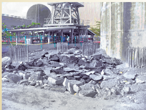
▲核能三廠冷凝水儲存槽（CST）環樑區耐震補強施工
