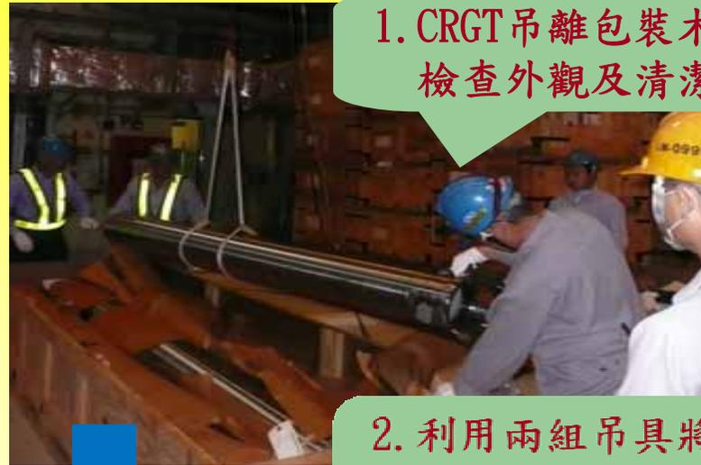
1. CRGT吊離包裝木箱並檢查外觀及清潔。
