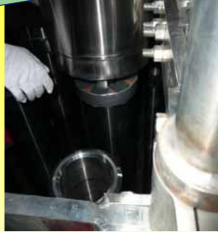
8. CRGT置放於臨時底座後改用手動吊具將CRGT緩慢吊入。
