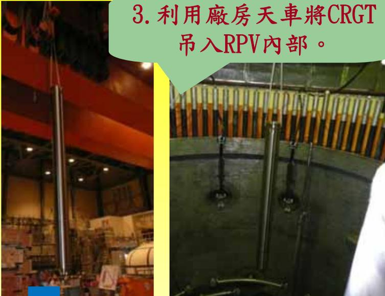
5. 工作人員在爐心底鈹協助CRGT順利穿過爐心底鈹至定位。
