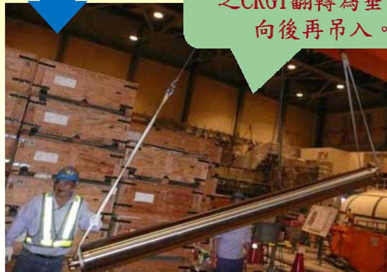
2. 利用兩組吊具將水平之CRGT翻轉為垂直方向後再吊入。
