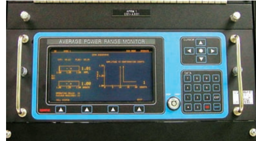
圖六 核能一廠功率階中子偵測系統
