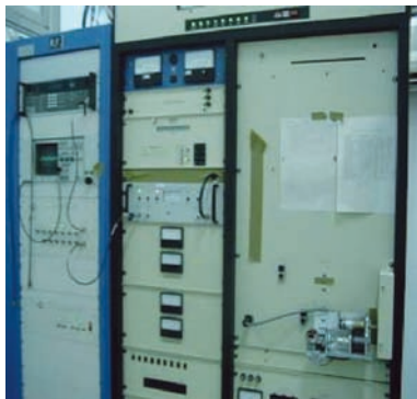
■ 圖一一二 (a) 原40 kW主放大器
