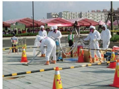
圖三十二 核能級吸塵器進行污染地面清除
