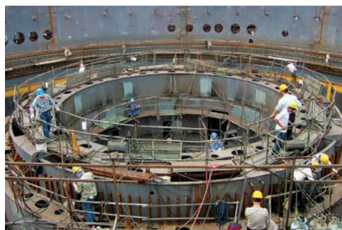
■ 圖十 核能四廠二號機基座第五層安裝作業視察
