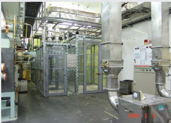
■ 圖六十七 隔離帳篷與負壓通風系統
