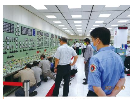
110 年 8 月 7 日查證核二廠 2 號機急停事件改善措施一控制室 設置盤面保護桿改善作業
