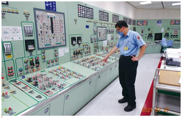
核二廠 2 號機 110 年 7 月 27 日急停事件控制室盤面查證 AEC inspector verified the MSIV control switch on control panel in the control room of Kuosheng NPP Unit 2.
