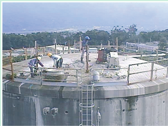
▲頂蓋切割作業
