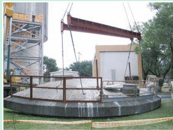
▲切割混凝土塊吊掛作業
