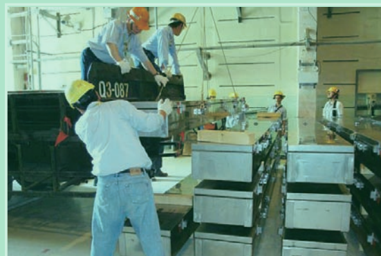
▲核子燃料運送箱吊卸作業空間安全餘裕不足，易致碰撞
