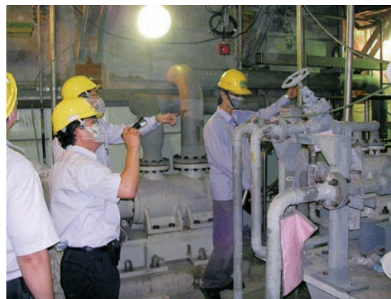
▲龍門計畫第39次定期視察作業情形
