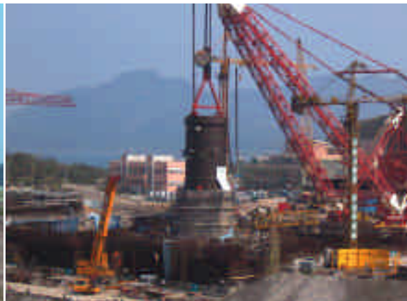
圖十三 RPV吊裝過程
