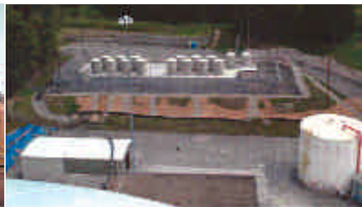
圖一 二 美國Yankee Rowe核能電廠用過核子燃料混凝土護箱貯存設施
