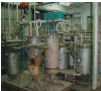
圖四十二 036U (UF 6 dispensing station) 拆除前
