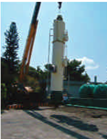
圖四十五 重機械吊拆作業
