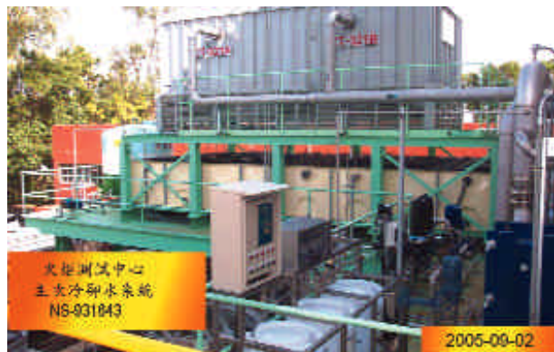
圖六十九 火炬之主次冷卻系統
