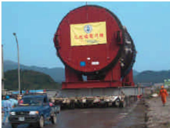
圖十二 RPV運輸過程
