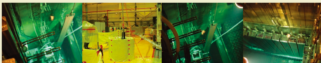
↑ 擠壓後的控制棒葉片裝入盛裝盒作業 ↑ 切除後的控制棒限速頭裝入廢料桶 ↑ 擠壓後安裝C型扣夾的控制棒葉片裝入盛裝盒作業 ↑ 控制棒葉片裝入盛裝盒後吊掛於燃料池邊盛裝盒掛架
