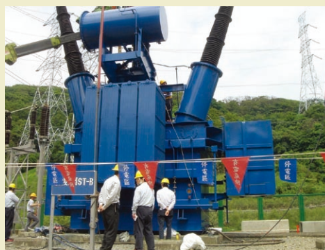
↑新變壓器安裝於基座情形
