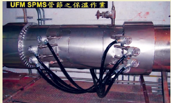
↑核能二廠超音波流量計系統 (Caldon LEFM CheckPlus)
