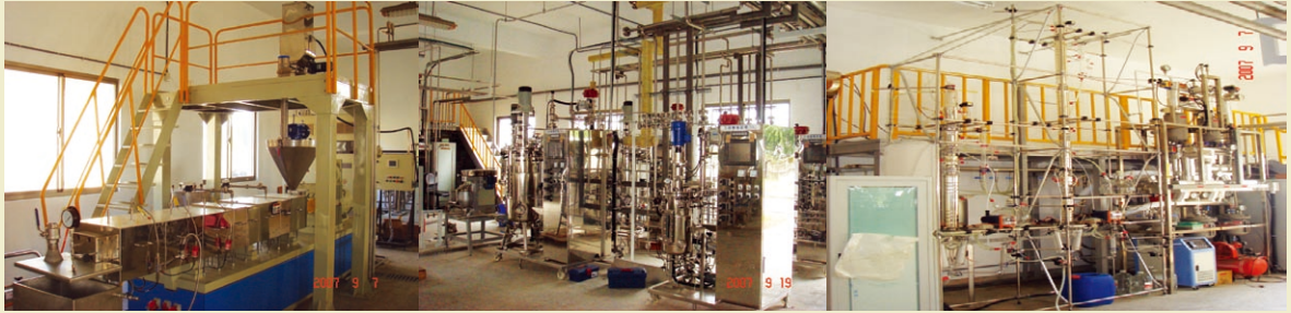
↑ 原料前處理系統—雙軸擠壓機
