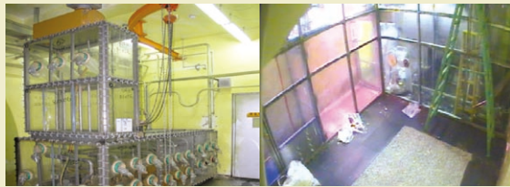
↑ 016館Unit20手套箱完 ↑ 016館Unit20手套箱拆除後
