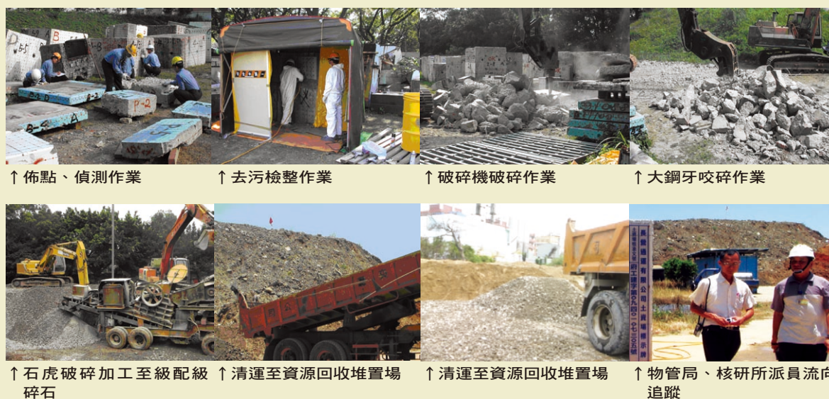
TRR濕貯槽拆除產生之混凝土塊外釋作業
