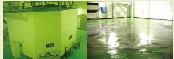
↑ 019館WBR生物屏蔽體 ↑ 019館WBR生物屏蔽體拆除後
