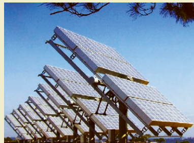
↑ 立柱式5kW及屋頂式1.5kW HCPV系統
