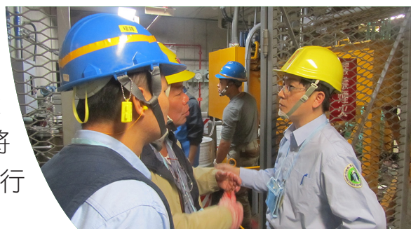
▲原能會視察員現場查證核一廠汽機廠房
