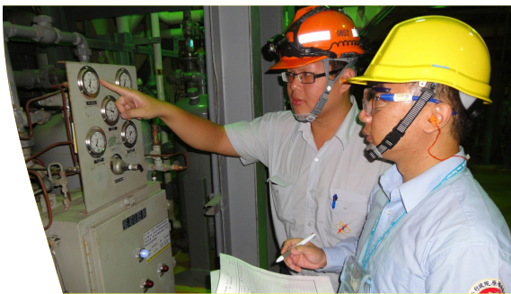
▲原能會視察員現場查證核三廠汽機廠房狀況及抄表紀錄
