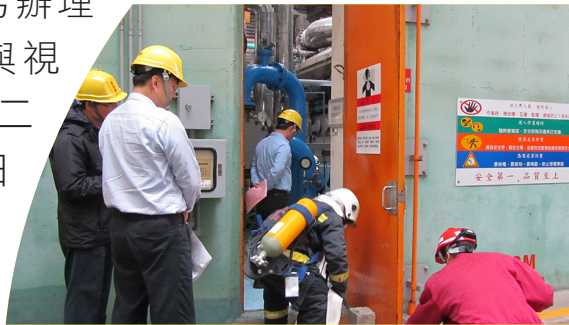
▲原能會視察員現場查證核二廠火災防護
