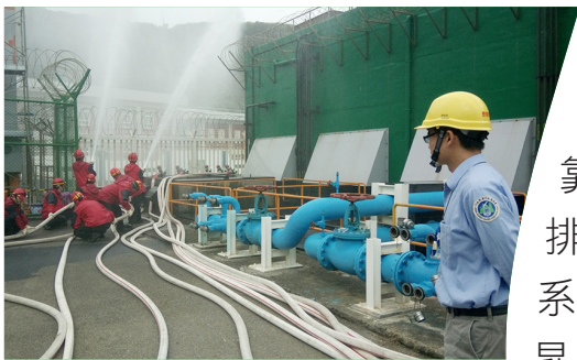
▲原能會視察員現場查證核一廠緊要海水主引接點注水
