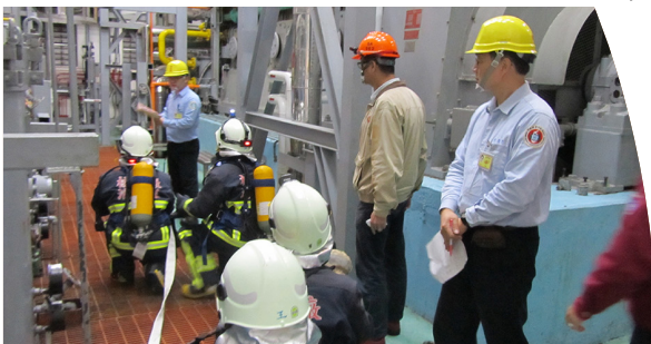
▲原能會視察員現場查證核二廠火災防護
