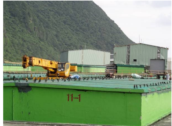
檢查未作業時壕溝密封情形
