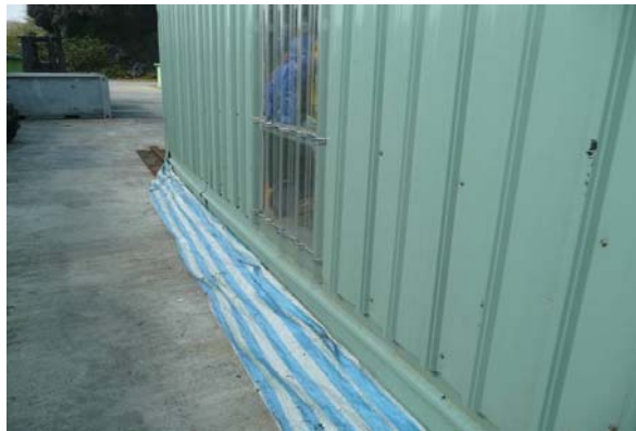
圖六 小型遮蔽物件帆布經 啟動負壓抽風後已契合
