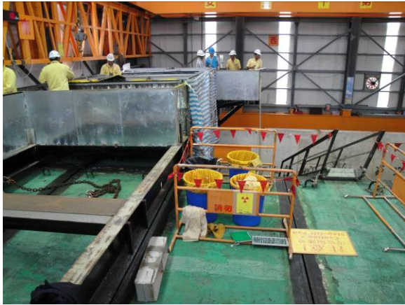
檢查遮蔽物件內吊桶作業
