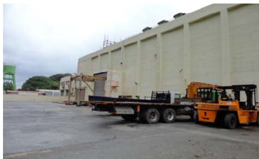
圖十 臨時鋼構遮雨棚已經拆除恢復空地
