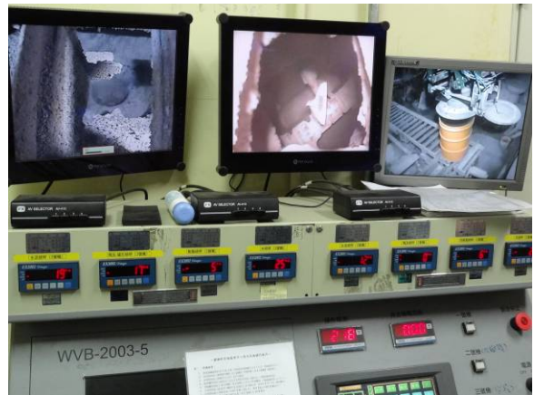
檢查固化作業
