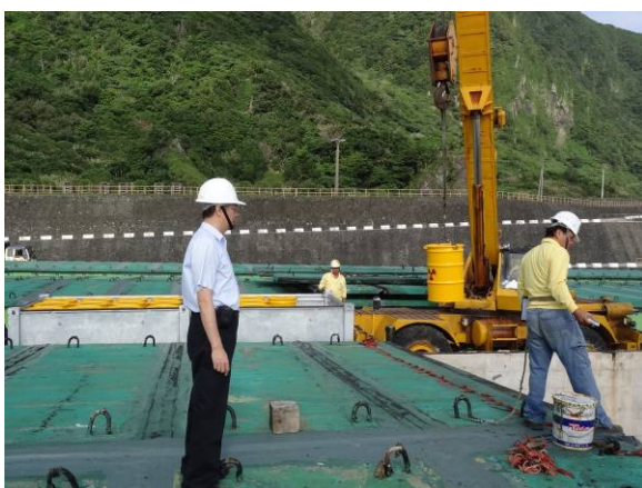
現場檢查回貯作業與工作紀錄
