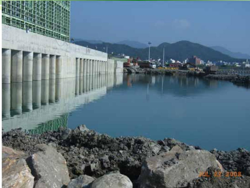
進水口圍堰破堤後，計劃可於9月中旬提供反應器廠房及汽機廠房相關設備之海水冷卻水源，有利於爐心緊急冷卻水系統噴晒測試，對建廠工程又向前邁進了一大步。
