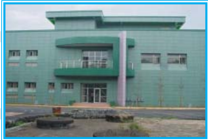
▲貯存設施作業廠房
