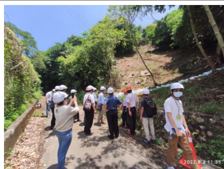
2022.8.3 山路現場狀況，坡上開路、坡面經整治、路旁有擋土牆與
